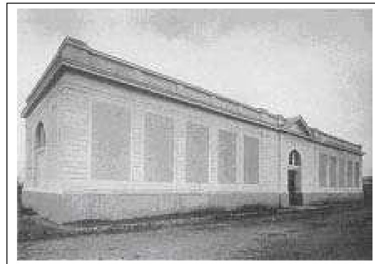
1911 : bâtiment des survolteurs
